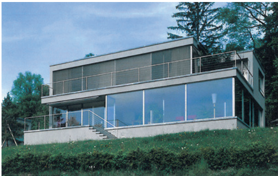
Abb. 12: Referenzbild Gebäude mit Sockel
