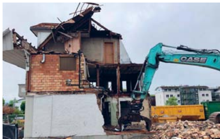
Rückbau Gärtnerei Rothenbühler
