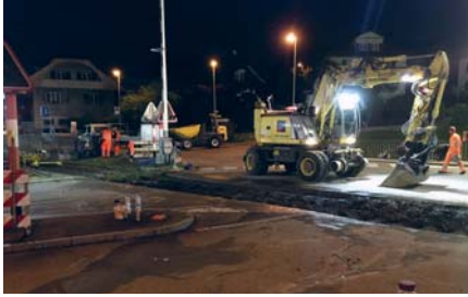
Nachtarbeiten beim Bahnübergang Steinibach
