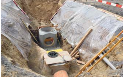
Neubau Kanalisationsleitung Schäferei
