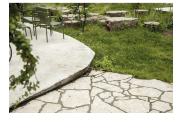
Wegausbildung mit Sichtkante / Vorteile für dem Umgang mit dem Terrain. Klinkerplätze mit Rasenfugen / offenen Fugen
