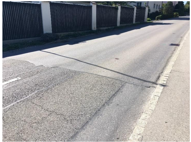
Abb. 2 Belagswechsel nach Erlachplatz Westliches Ende des Sanierungsperimeters
