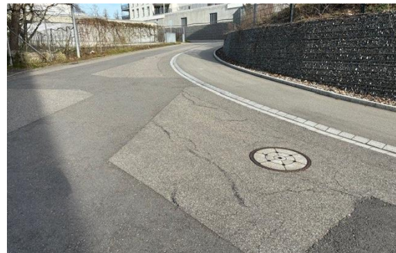
Abb. 2 Belagsschäden (Lätternweg 34) Dunkler Belag Fernwärme Heller Belag = alter Deckbelag mit Rissen Alte Schachtabdeckung Kanalisation
