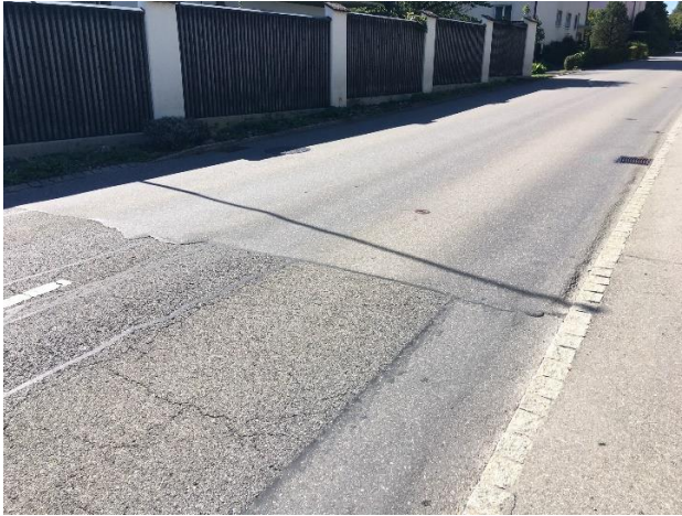
Abb. 2 Belagswechsel nach Erlachplatz Westliches Ende des Sanierungsperimeters
